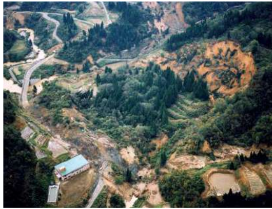
地滑りにより道路が寸断された山古志地域の当時の様子
